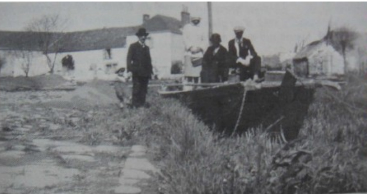
Photographiée à Rohars, une toue telle que celle que Jean Legland a utilisée pour ses traversées de la Loire ; les passagers sont des descendants du passeur.
