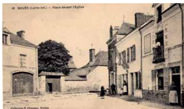
Place de l'église. Le portail d'accès à la maison du bourg est devenu un porche.
