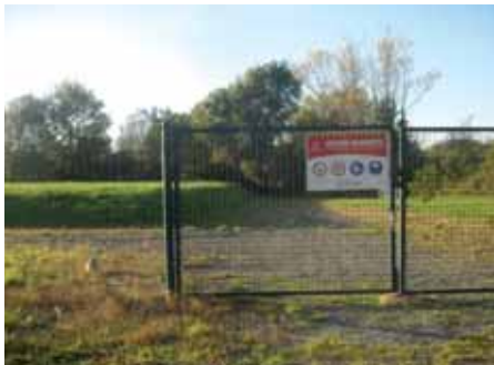
Station d'épuration actuelle
