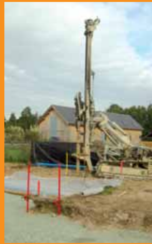
Forage géothermique.
