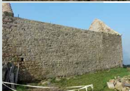
Mur nord avant et après restauration par les bénévoles
